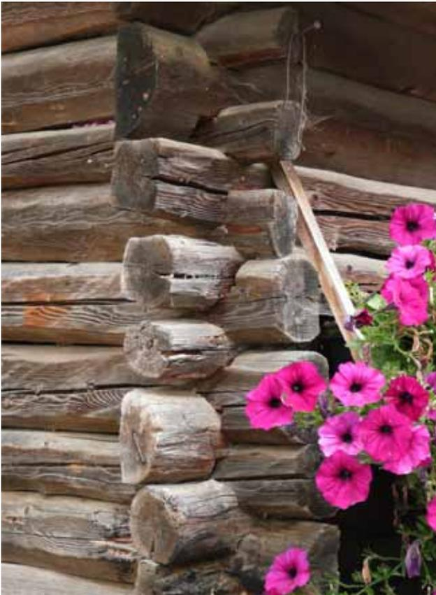
Chiusura verticale realizzata in legno con la tecnica tradizionale del block bau.
